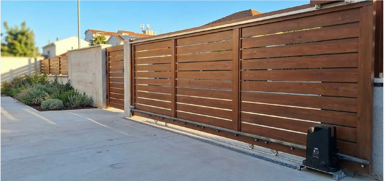
Klizna kapija s elektromotorom
